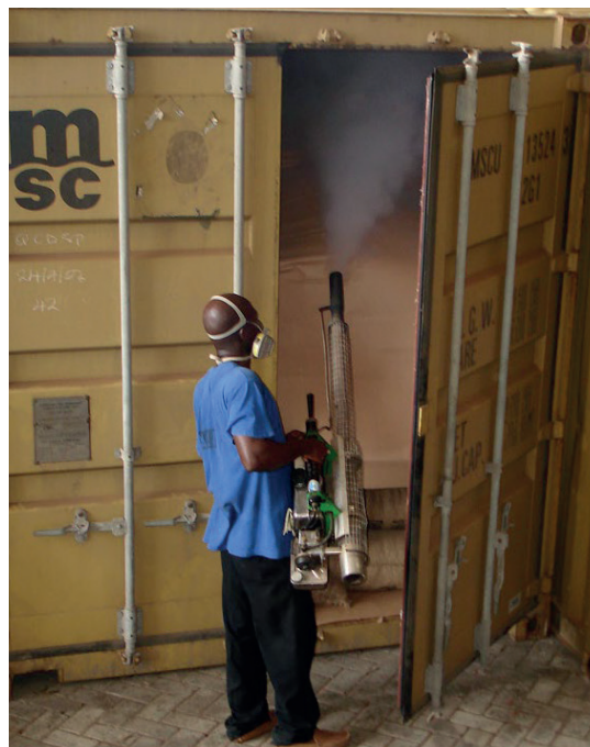
b. Tratamiento del espacio con una formulación piretroide de volumen ultra-bajo, utilizando un nebulizador térmico, antes de cerrar el contenedor
